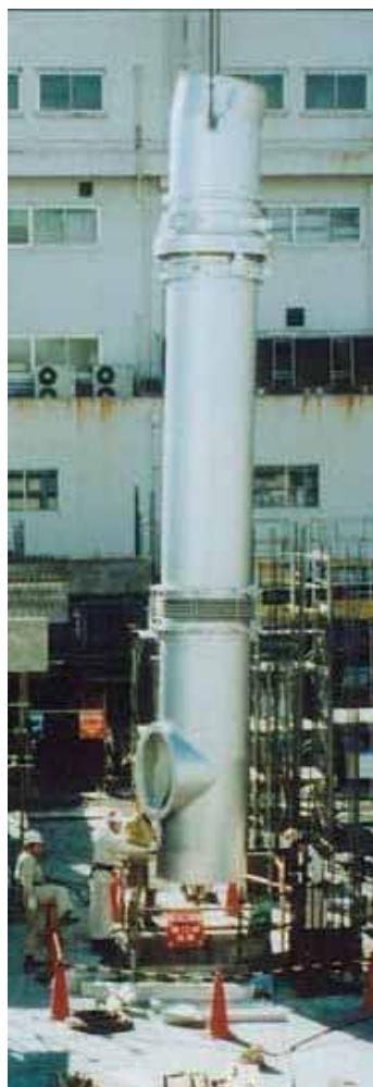
← 建設時の煙突免震継手
